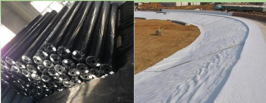
土工布的现场铺设
