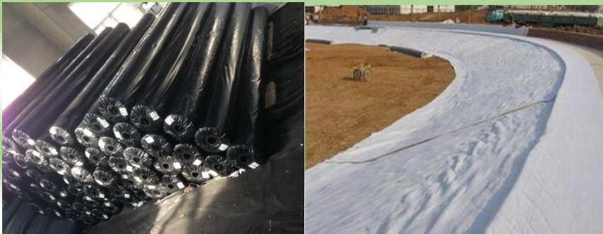
土工布的现场铺设
